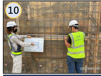
鋼筋(牆)施工監造查驗
