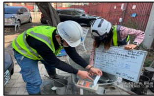
混凝土材料取樣
