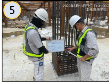
鋼筋(柱)施工自檢
