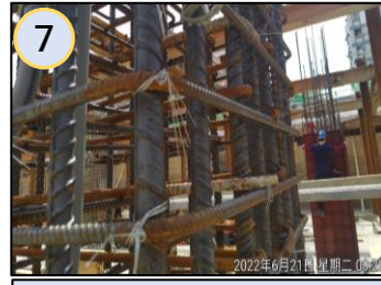
保護層施工自檢
