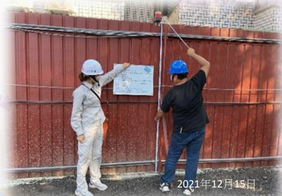
施工圍籬抽查
