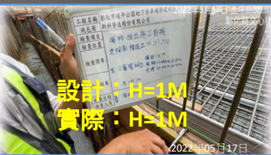
B1F內牆鋼筋間距抽查
