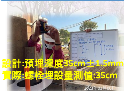
鋼構F1基礎預埋螺栓抽查
