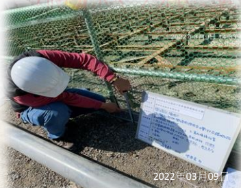
安全輔助設施抽查
