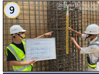
鋼筋(柱)施工監造查驗
