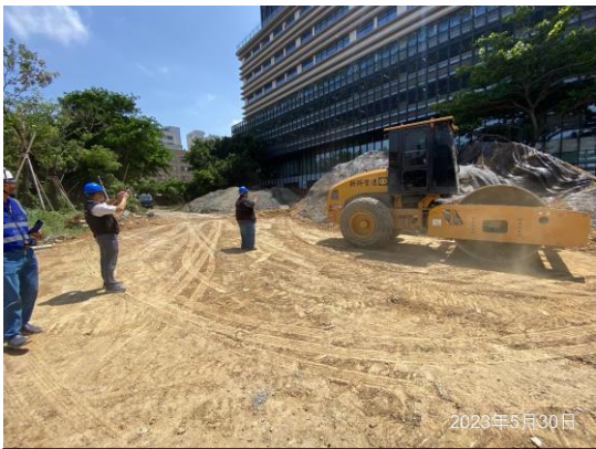
2023年5月30日 施工機具清潔排放
