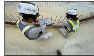
景觀區邊墩模板自檢
