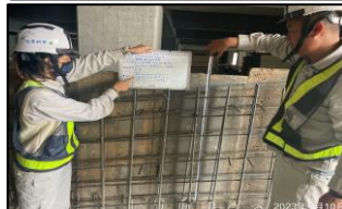
車道出入牆面鋼筋自檢
