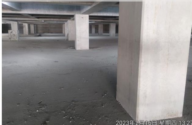
156根中間柱澆置後情形
