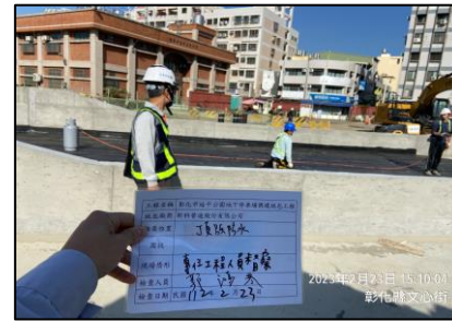
景觀防水毯施工督察
