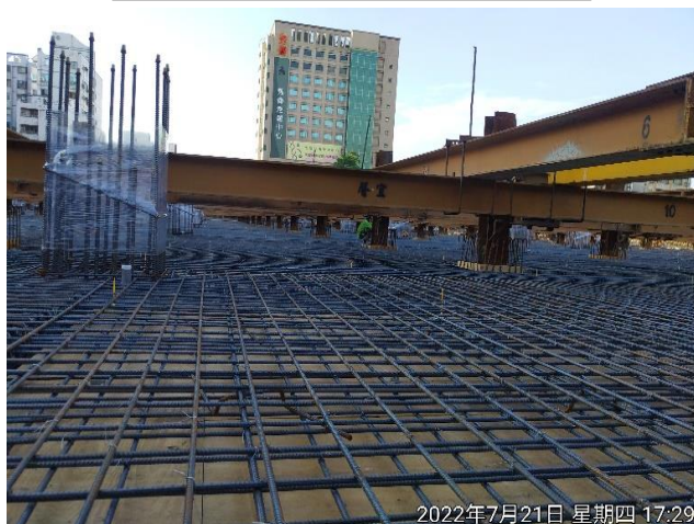
柱筋保鮮膜 防止澆置時汙染鋼筋
