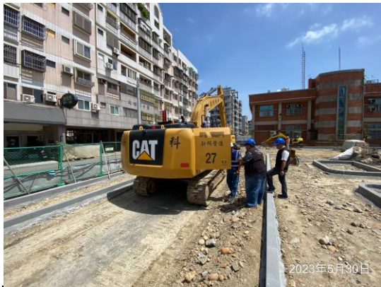
2023年5月30日 施工機具清潔排放
