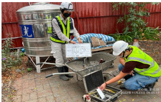
低強度混凝土澆置取樣
