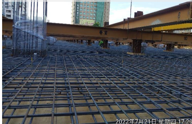
柱筋保鮮膜 防止澆置時汙染鋼筋
