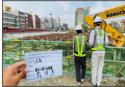
開挖水平支撐督察
