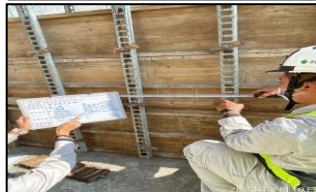
丁梯牆面模板自檢
