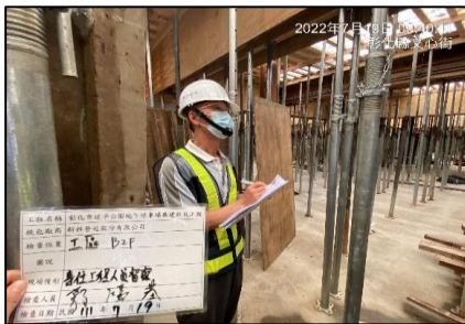
模板鋼管組立督察
