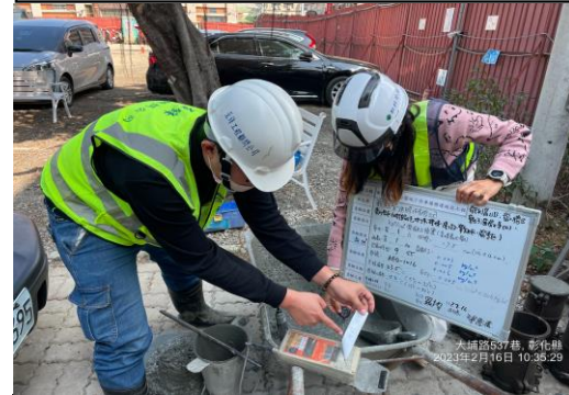
混凝土材料取樣
