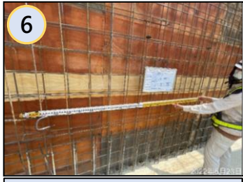
鋼筋(牆)施工自檢
