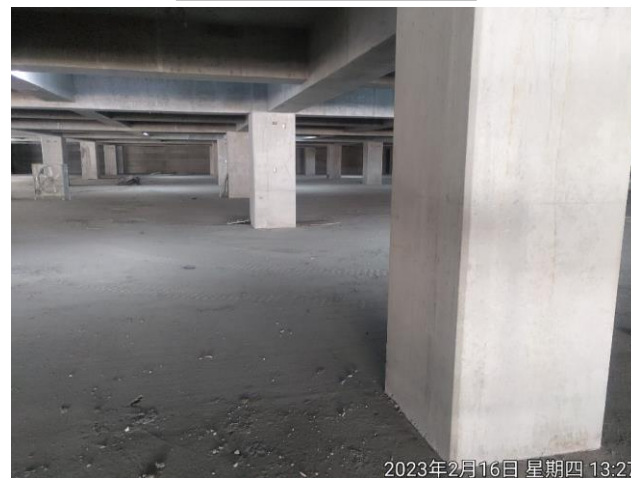
156根中間柱澆置後情形
