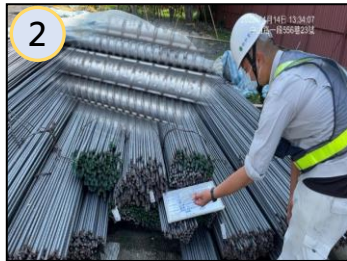
現場鋼筋進場材料自檢
