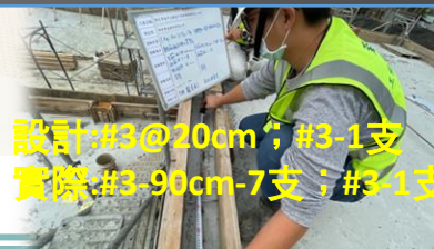
R2F止水墩鋼筋抽查
