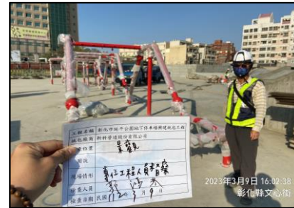
遊具組立施工督察
