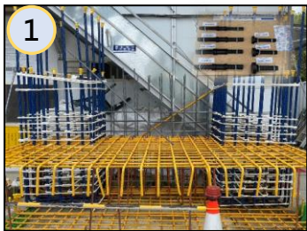
鋼筋工法展示
