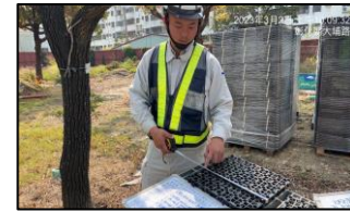
景觀排水板材料自檢
