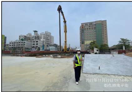
鋼板樁拔樁督察
