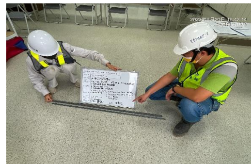
鋼筋材料取樣
