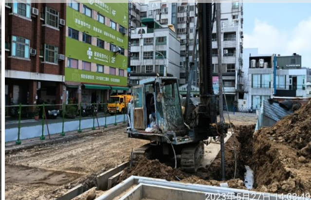
工區自主高壓灌漿200支(間距1.5m)
